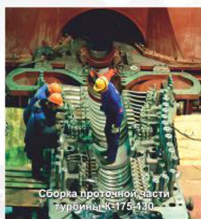
Ремонт проточной части ЦНД турбины К-160-130
