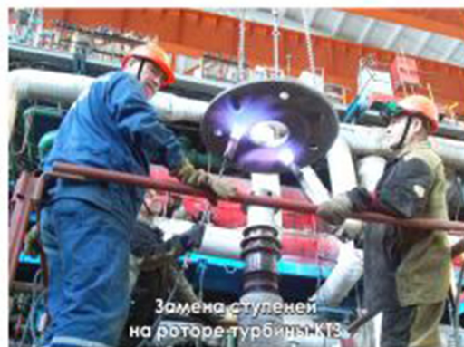
Ремонт проточной части турбины К-160-130
