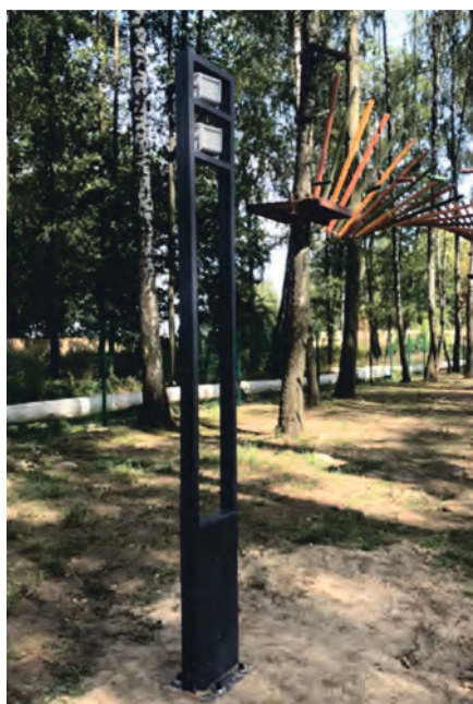
Опора «Техно», г. Гомель, ОАО «Химремонт»
