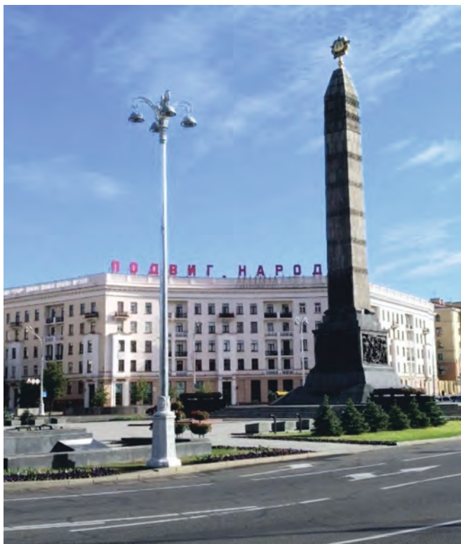
Опоры конусные с кронштейнами, выполненными методом высокохудожественного литья, г.Минск, площадь Победы
