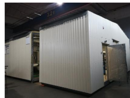
**Строительство электрической котельной, совмещенной с трансформаторной подстанцией, блочно-модульного исполнения, с напряжением 0,69 кВ, позволяет сэкономить до 40% на капитальных затратах при строительстве объекта, по сравнению с традиционным исполнением блочно-модульной котельной.**
