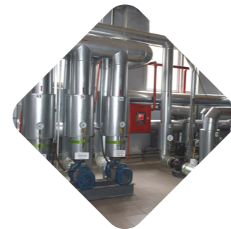
«СТРОИТЕЛЬСТВО ОТДЕЛЬНО СТОЯЩЕЙ КОТЕЛЬНОЙ НА ФРЕЗЕРНОМ ТОРФЕ НА ТЕРРИТОРИИ КОТЕЛЬНОЙ № 3 В СЛУЦКЕ»
