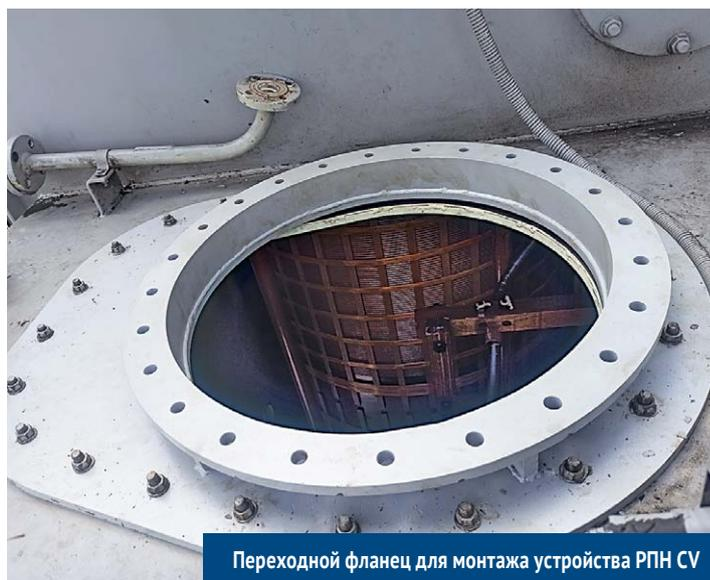
Переходной фланец для монтажа устройства РПН CV
