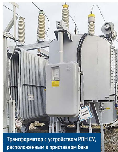
Трансформатор с устройством РПН СВ, расположенным в приставном баке
