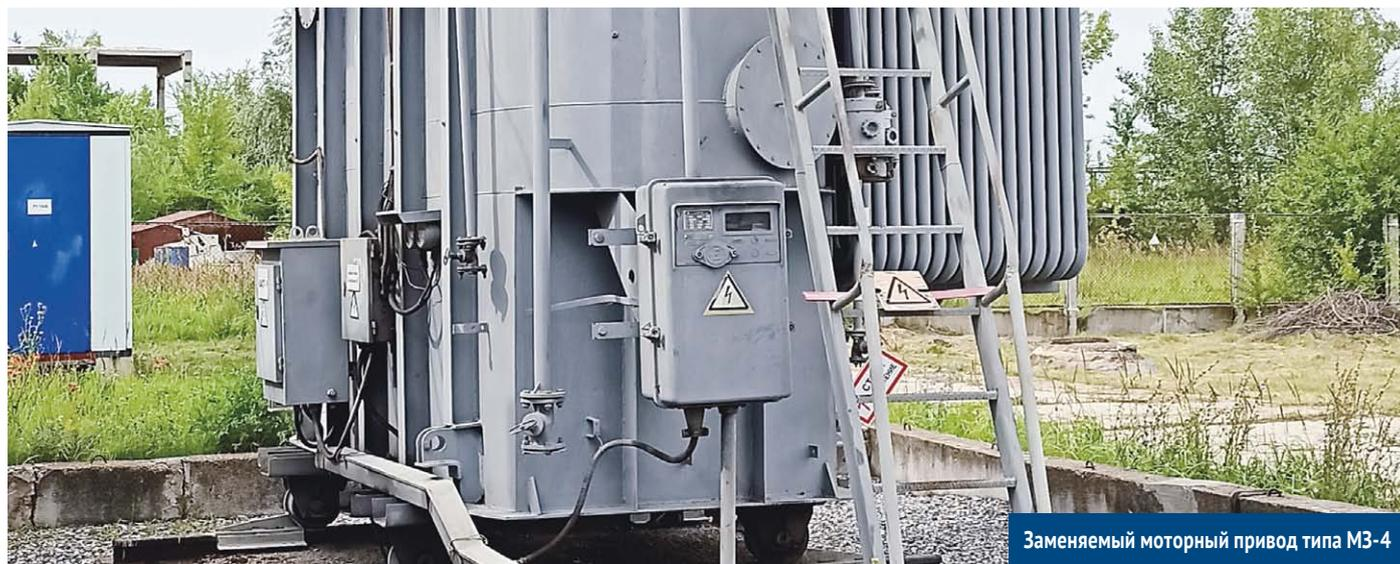
Заменяемый моторный привод типа МЗ-4
