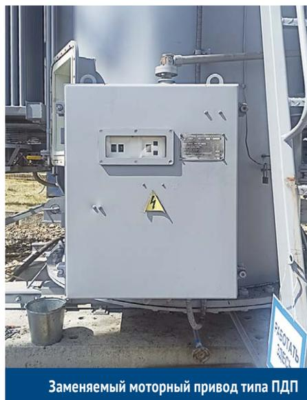
Заменяемый моторный привод типа ПДП
