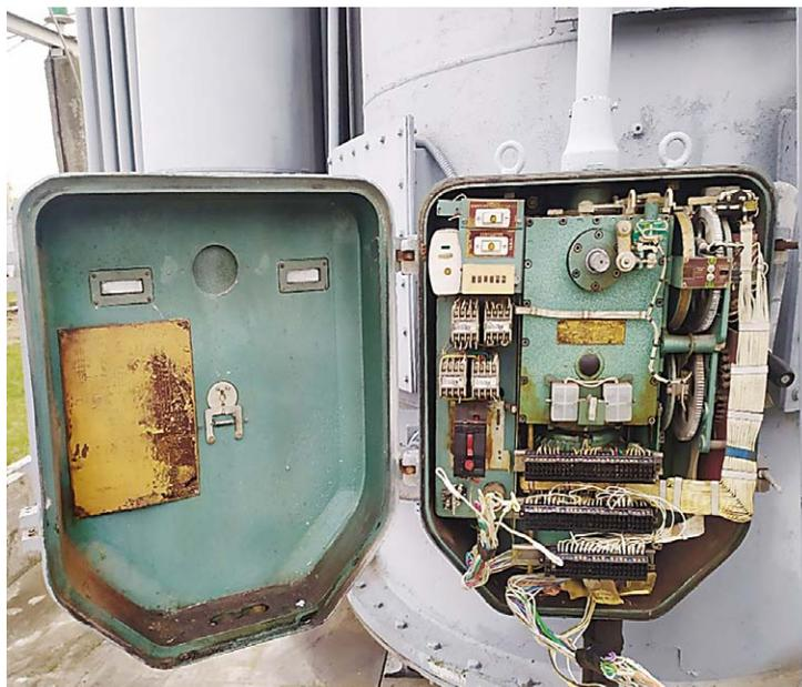
Заменяемый моторный привод типа МЗ-2
