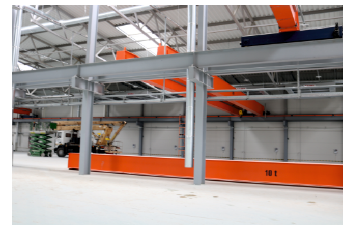
Монтаж кранов в здании нового цеха
