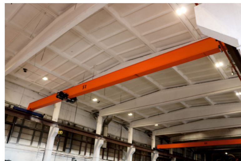
Кран мостовой опорный однобалочный г/п 5 тонн для нужд собственного производства
